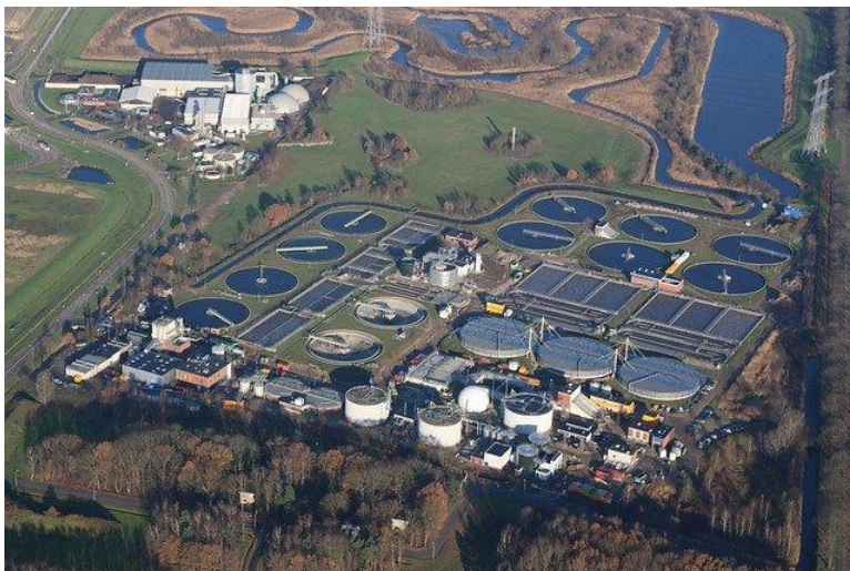
Figuur 2 Luchtfoto van RWZI Tilburg (bron: Waterschap De Dommel).
